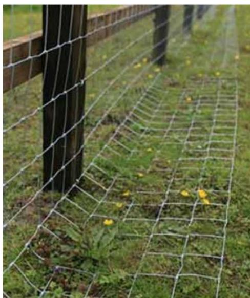
Figura 42 - Exemplo da porção inferior da cerca do tipo saia com 40 cm. Fonte: Belgo Bekaert.
