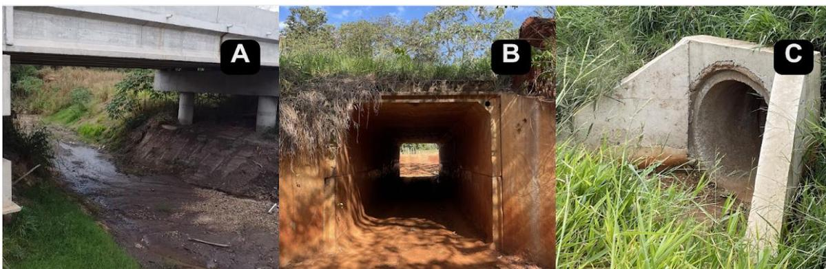
Figura 31 - Tipos de passagens inferiores presentes nas rodovias amostradas: (A) Ponte sobre córrego, MS-345; (B) BSCC, MS-178-N; (C) BTCC, MS-345. Fotos: Amanda Messias.
